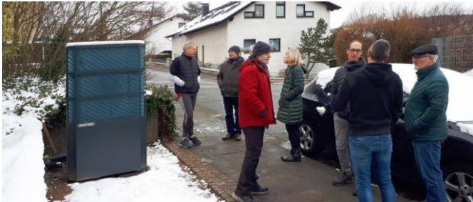
Bild: Die besichtigte Wärmepumpe mit fasst allen Vorstandsmitgliedern und zwei Ehefrauen vor Besichtigungsbeginn, Foto: REG.eV | K. Pfeifer
