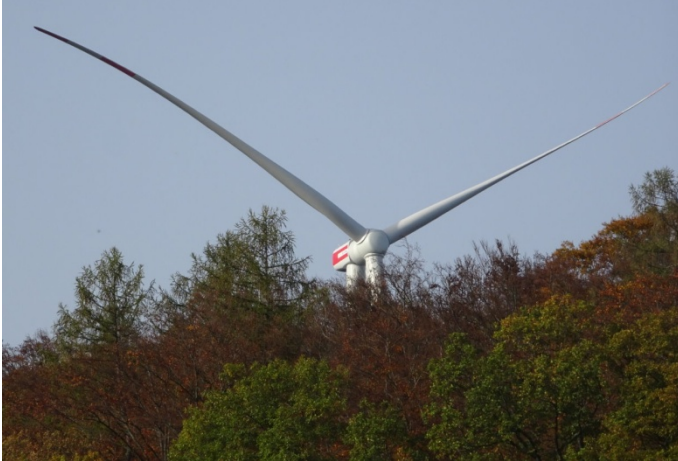
Bild: Windrad in Ober-Ramstadt Anfang November 2020 vor der Inbetriebnahme, Foto C. Nintzel
