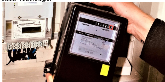
Bild: Zählertausch grau gegen schwarz, Foto: ComMetering
