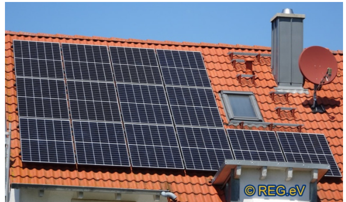
Bild: Fertige PV-Dachanlage vom 26.06.2020 in Gundernhausen
