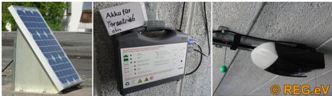
PV-Garagentoranlage mit (von links) Photovoltaik-Modul mit 30 Watt, tragbarer Akku, der ggf. am Netz nachgeladen werden kann und der Torantrieb mit Licht für wenige Minuten
