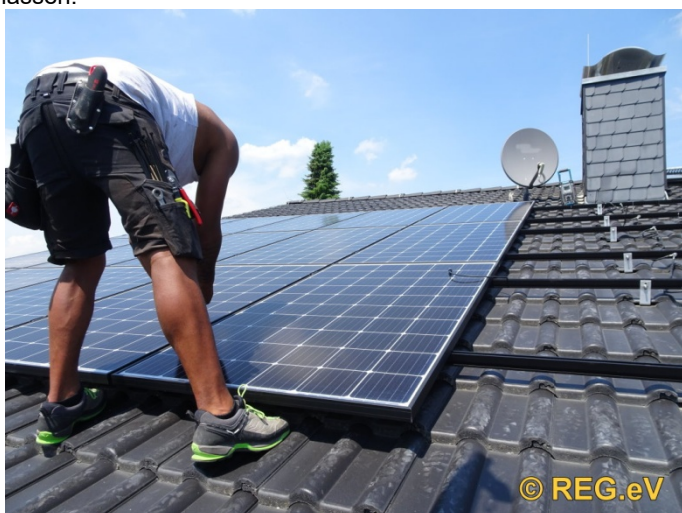
Dachmontage im Projekt „Weitere Sonnendächer 2019“
