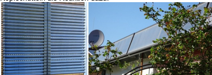
Bild: links die beiden Röhrenkollektoren senkrecht auf der Außenwand, rechts Flachkollektoren auf 72 Grad geneigt
