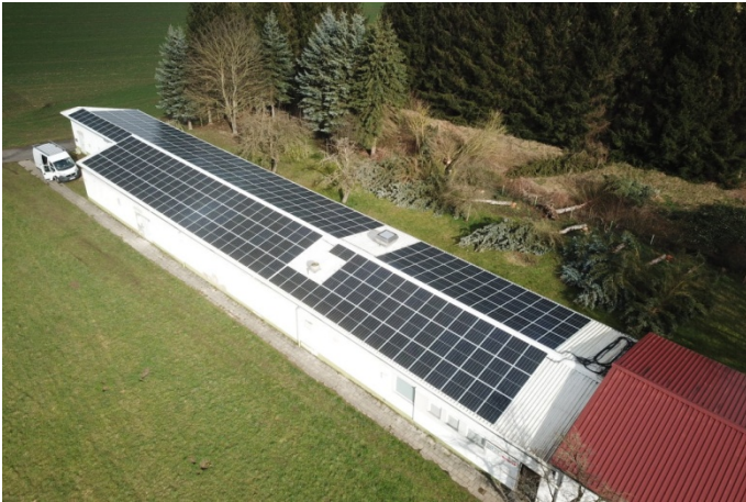
Bild: Luftaufnahme der Schießanlage mit 272 Photovoltaik-Modulen, Foto: Energiegenossenschaft Starkenburg eG.
