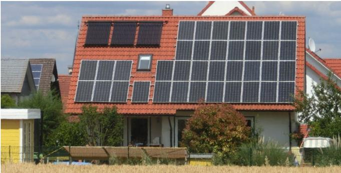
Bild: Solarthermie (oben links) und Photovoltaik auf Hausdach
