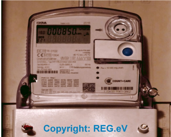
Bild: Anzeige- und Bedieneinheit einer modernen Messeinrichtung (mME) am Beispiel der Fa. ISKRA, Lichtsensor oben rechts
