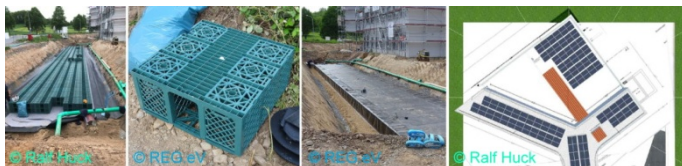
Bild (v. li.): Innenleben der Zisterne; „Bierkasten“; Zisterne eingepackt vor Verfüllung; Modul-Anordnung der PV-Anlage
