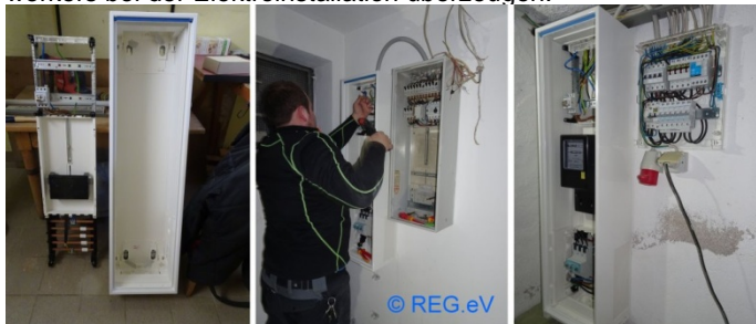
Bild: „Eingeweide“ und neuer Zählerschrank; Verdrahtungsarbeiten; Zähler im neuen Schrank, Strom kann wieder fließen
