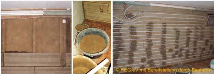
Bild: Links Wandaufbau mit senkrechten Holzlatten, Dämmplatten bis halbe Höhe und Verfüllung Zwischenraum; Mitte Lehm-gemisch in Kübeln; rechts Wand mit Heizschlangen
