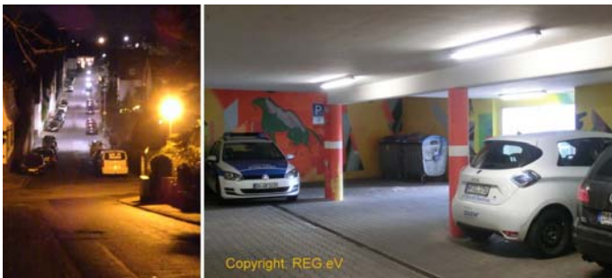
Bild: links Wingertstraße mit gelblicher Natriumdampf-Hochdruckleuchte und LED-Leuchten im unteren Teil; rechts Tiefgarage mit Ausfahrt zur Löwengasse nach Umrüstung
