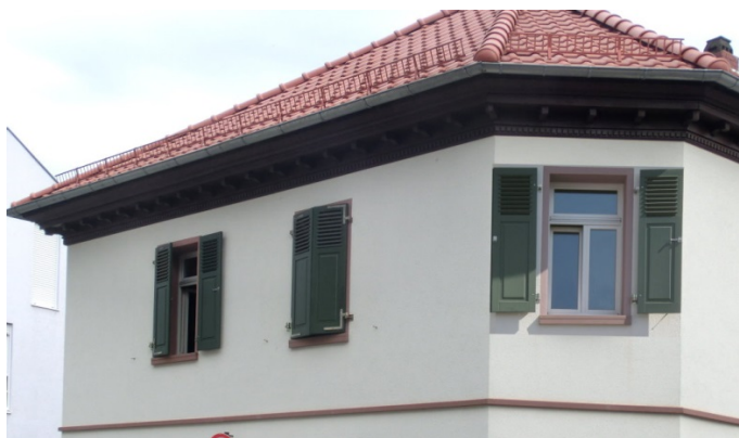
Energetisch saniert: Schwanengasse 1 in Roßdorf (Teilansicht Obergeschoss), Foto © REG.eV
