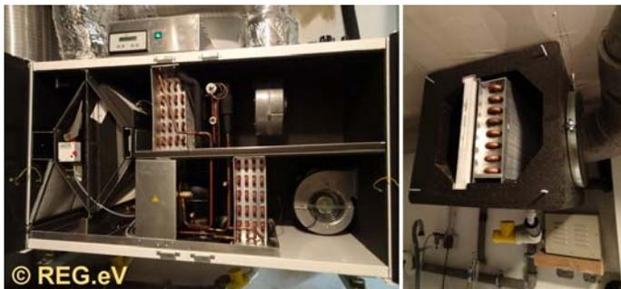
*Heizsystem mit (von li.): Zentralgerät der Frischluftheizung (Frischluft von oben links, Raumluft von unten links, Sommerbypass, Gegenstromwärmetauscher, Luft/Luft-Kleinwärmepumpe, Ventilator für Abluft nach außen oben rechts, Ventilator für Frischluft ins Haus unten rechts sowie Sole-Erdwärmetauscher (PTC-Elemente nicht abgebildet, da in Rohren montiert)*
