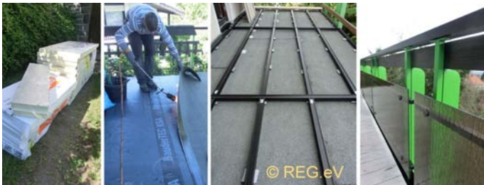
Bild (v.li.): Dämm-Material 2 x 5 cm aus PU alukaschiert; letzte Schicht des Dachdeckers heiß verklebt; Alurahmen lose verlegt mit 2% Gefälle des Balkons; Holzbelag fertig mit Klammern verschraubt; Balkonbrüstung mit Vierkantrohren zur Erhöhung
