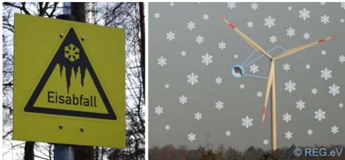
Bild: Warnschild und Symbolisierung Schwingungsdetektoren in jedem Rotorblatt
