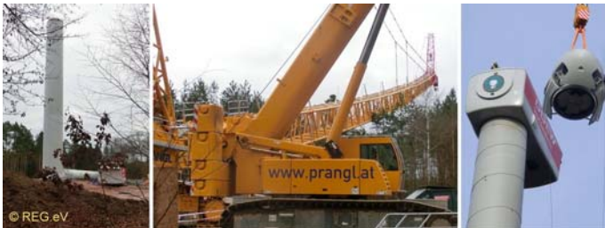
Bild (von links nach rechts): Nördlicher Bauplatz mit drei Segmenten des Stahlturms (ca. 45 m hoch), daneben Maschinenhaus; Südlicher Bauplatz: Aufrichten des riesigen Kranauslegers am Dienstanachmittag (Gesamthöhe ca. 140 m) sowie Montage der Nabe am Maschinenhaus auf 120 m Höhe gegen 15 Uhr am Samstag
