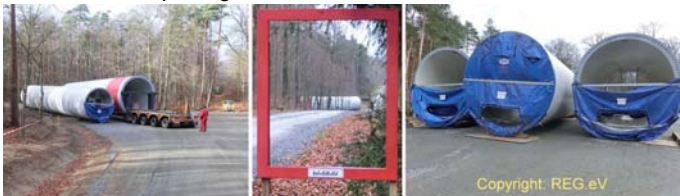
Bild: Links und Mitte zwei Turmsegmente in der Abbiegung von Hauptschneise zum südlichen Bauplatz, rechts drei Turmteile auf dem nördlichen Bauplatz, jeweils zwischengelagert
