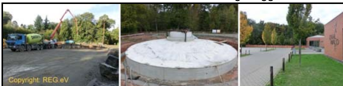
Betonierung am nördl. Bauplatz; fertiges Fundament am süd. Bauplatz; Arbeiten zur Kabeltrasse an der Zahlwaldhalle
