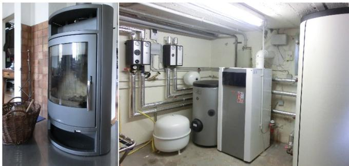
*Bild: Wassergeführter Kaminofen und Kellerraum mit Ölbrennwertheizung und Pufferspeicher*
