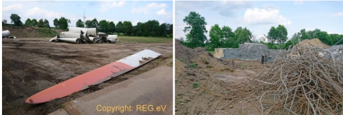
Bild: Abbau einer Windkraftanlage in Norddeutschland: links zersägte Rotorblätter, rechts teilweise zerstörtes Fundament für Recycling
