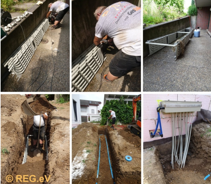
Bild: Montagearbeiten der Erdkollektoren mit Verbinden der „Heizkörper“ (obere Reihe), Verfüllen und Einschleppen des Grabens, Verteilerkasten am Haus und fertige Hauseinführung
