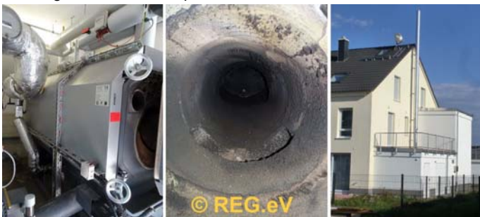
Pellet-Heizkessel (102 kW) mit geöffneter Brennkammer in der Heizzentrale
