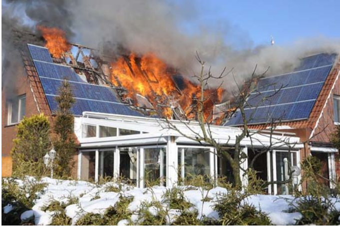
Brand bei einem Wohnhaus mit Photovoltaik-Anlage (Bildquelle: B. Wolters Leer)
