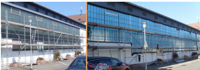
Bild: Bürgerhaushalle Gundernhausen vor und nach der Fassadenerneuerung (Bildquelle: Gemeindeverwaltung Roßdorf)
